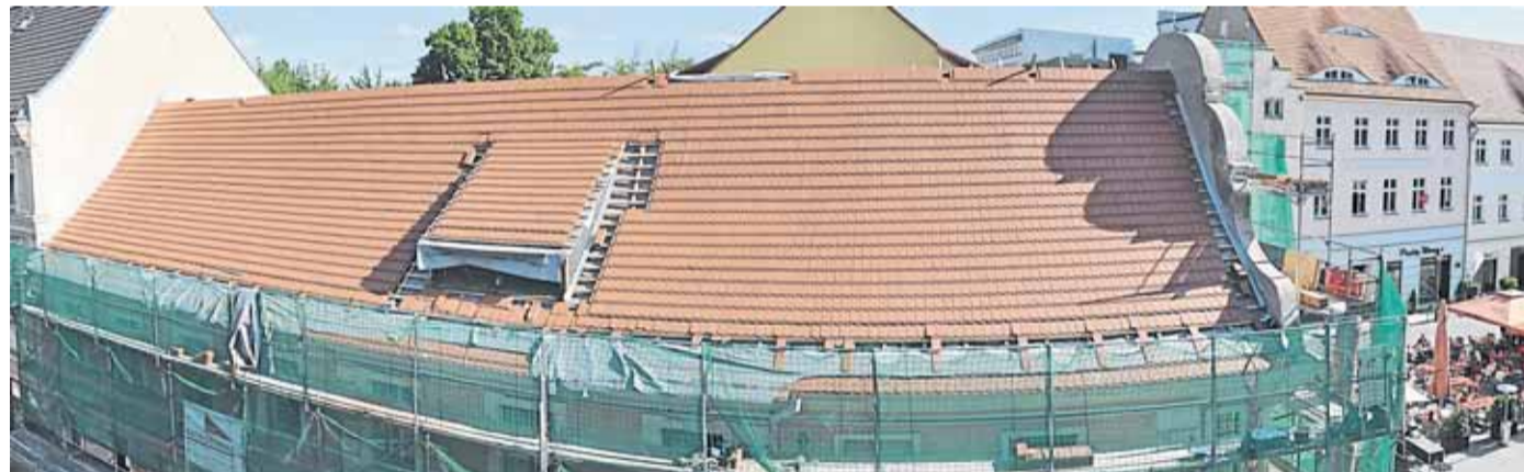
Blick von der Sandower Straßenseite auf das 420 Quadratmeter große Dach an der Altmarkt-Ecke. Die Gaube wird mit Schiefer verkleidet. Der Schmuckgiebel erhält ein neues Zinnkleid - wegen der vielen Bögen ebenfalls eine Herausforderung
