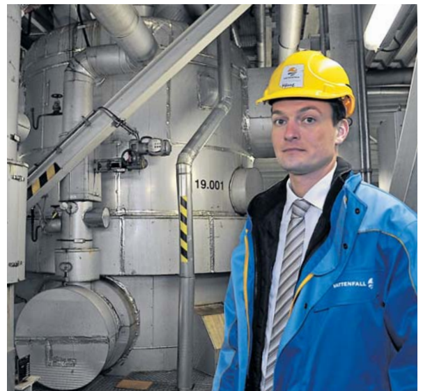
Projektleiter Olaf Höhne vor dem Herzstück der Anlage: In dem Kessel im Hintergrund, der über mehrere Etagen reicht, wird die zerriebene Rohkohle mit Dampf aufgewirbelt und dann unter Druck und Hitze getrocknet. Links: Die Anlage (r.) mit den Förderbandtrassen zu den Gebäuden der Veredlung von Vattenfall Fotos: Jens Haberland
