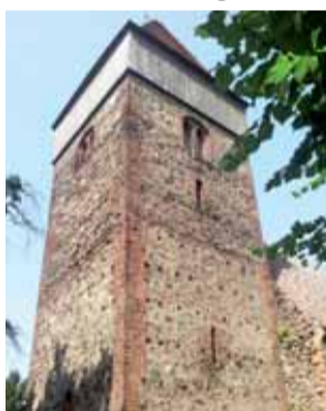
Hat wieder Zukunft: die Steinitzer Feldsteinkirche
