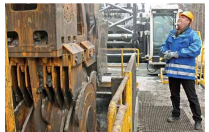
Der Fräskopf einer der zwei neuen Schlitzfräsgeräte VB 130 am Tagebau Welzow Süd. Sie können die Dichtwand bis in 130 Meter tiefe Tonschichten wasserdicht einbinden. Die Tonschichten der Dichtwand sperren das Grundwasser zuverlässig seit über 30 Jahren ab
