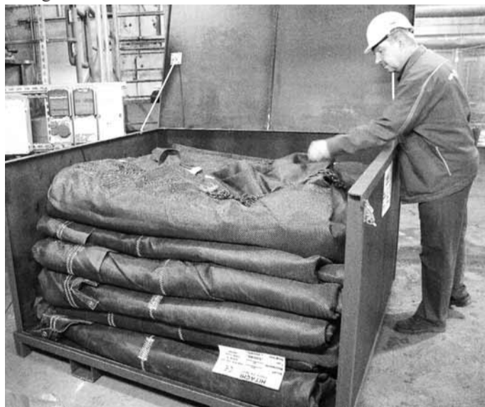
Michael Tschernig, Revisionsleiter beim Instandhaltungsmanagement im Kraftwerk Boxberg, überwachte die Montage der Sicherheitsabschottung
