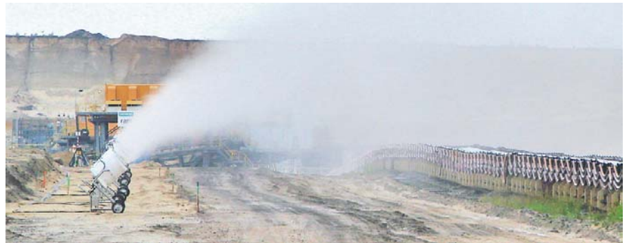
Nebelkanonen sprühen mikrofeine Wassertropfen zehn Meter hoch und 50 Meter weit und können ebenso kleine Staubkörner erfassen - damit wird sogar Feinstaub gebunden. Allerdings müssen die Kanonen mit gefiltertem Trinkwasser bestückt werden. Diese rund 300 Meter lange Galerie wurde vor der Schutzwand von Grieben aufgestellt. Fotos: Vattenfall
