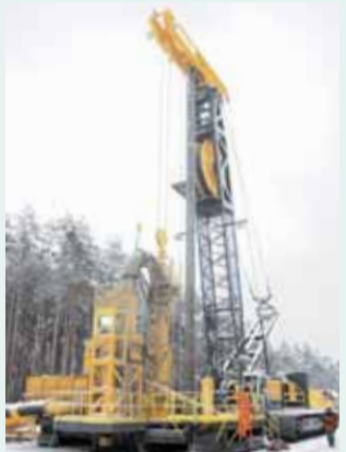
Eine solche zweite Dichtwandfräse der neuesten Generation ist jetzt südlich vom Tagebau Welzow-Süd im Einsatz Foto: J. Ha.
