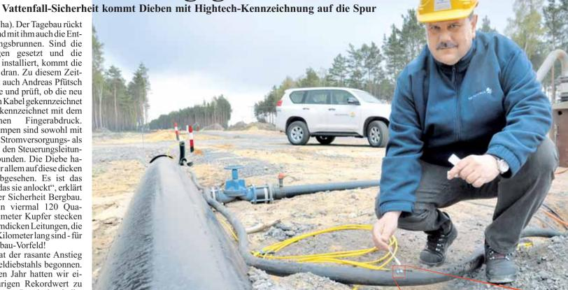
Vattenfall-Sicherheitschef Andreas Pfütsch markiert ein Stromversorgungskabel für Grundwasserpumpen im Tagebau-Vorfeld. Die anfangs weißliche Flüssigkeit mit den winzigen Datenplättchen - im kleinen Bild deutlich zu erkennen - ist nach dem Aushärten unsichtbar und nicht mehr ablösbar, selbst Feuer und Schreddern kann den Plättchen nichts anhaben
