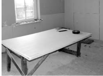
In drei Monaten soll das Haus Karl-Liebknecht-Straße 4 eine Pension mit 16 Betten sein
