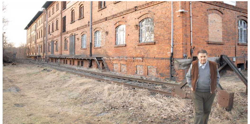
Die Gleise vor dem Gebäude wurden bereits freigeschnitten. Im Gebäude selbst soll mit so ziemlich allem gehandelt werden, was es gibt: Pelletsheizkessel, polnische Äpfel aber auch deutsche Waren
