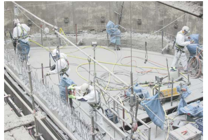
Schwerste Handarbeit in fast 300 Metern Höhe: Nur per Hand konnten die Mitarbeiter der TVF Altwert die oberen Meter der inneren doppel-D-förmigen Röhre abtragen
