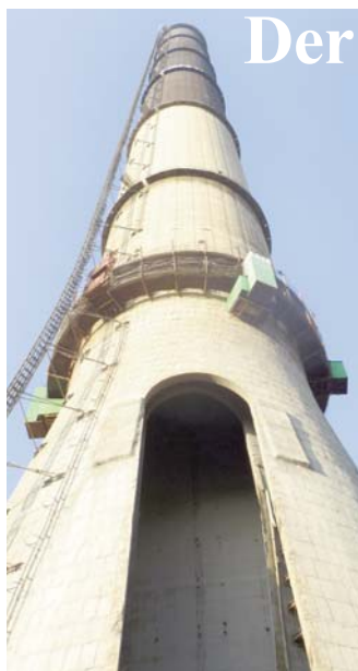
Der dritte und dickste Schornstein: Der Blick in die Öffnung zeigt deutlich die Doppelwandigkeit. Mit solch einer inneren Röhre waren alle drei Schlote ausgestattet, die an der Mündung in 300 Metern Höhe noch einen Meter hinausragten. Rechts: Blick in den Schornstein von oben, wo bei Höhe 255 Meter die „SAK 30“ die Abbrucharbeiten übernehmen konnte
