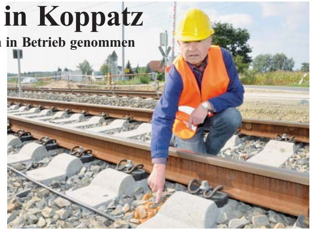
Konrad Kiel, Baustellenleiter und Koordinator für die Ertüchtigung der Kohleverbindingsbahn, zeigt auf den weichen Schaum, in den die Schwellen gebettet sind. Der Schotter darüber dient zum Schutz. Die Spezialschwellen liegen deutlich enger und bieten eine breitere Auflagefläche für die Schienen Fotos: J. Haberland
