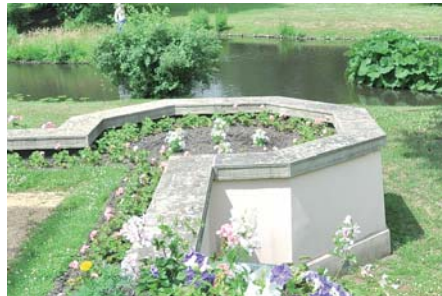
Diese unscheinbare Mauer hat handwerkliches Können gefordert: Die leicht schrägen Mauern wurden Stein auf Stein passgenau per Hand gesetzt. Der Fuß hat Lüftungsöffnungen mit Gusseisen-Abdeckungen erhalten
