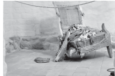
Auch innen, hier im Keller der Gutsökonomie, wurden hochwertige Materialien in ungewöhnlicher Umgebung verbaut. Am Rand sind die Feldsteinfundamente zu erkennen, der Boden ist mit Backsteinen belegt
