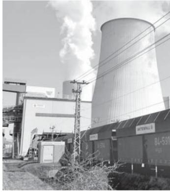
Neben den generalüberholten Großgeräten wurde vor dem Start eine neue Bandanlage gebaut, die das Kraftwerk Boxberg sowohl aus dem Tagebau Reichwalde als auch aus dem Nochtener Feld mit Kohle versorgt. Eine Zugverladestation gibt es am Kraftwerk für die Belieferungen der Kraftwerke Schwarze Pumpe und Jänschwalde
