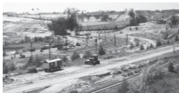
Auf Kleinbild-Fotos im Sekundentakt hat Klaus Wahn die Sprengung der Förderbrücke „F22“ im Juni 1995 festgehalten. Diese zweite Förderbrücke wurde wegen stark gesunkenen Nachfrage nicht mehr benötigt. Die „F27“ arbeitet bis heute zuverlässig, dank regelmäßiger Modernisierung
