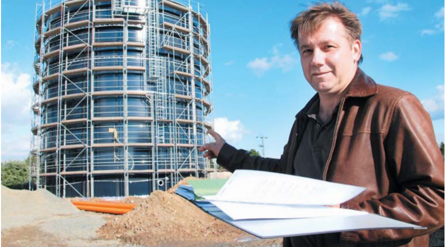
Bernd Starick, Vorstand der Bauern AG Neißetal, vor dem Herzstück der entstehenden Biogasanlage in Grießen - dem Fermentierer. In den nächsten Tagen wird mit 3 500 Kubikmeter Wasser die Dichtigkeit geprüft. Rechts: Der Blick ins Innere des Silos mit dem gut drei Meter breiten Hightech-Quirl. An Material und Konstruktion wurden höchste Ansprüche gestellt, denn hier wirken dann aggressive Stoffe
