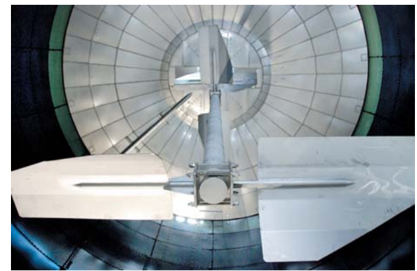
Bernd Starick, Vorstand der Bauern AG Neißetal, vor dem Herzstück der entstehenden Biogasanlage in Grießen - dem Fermentierer. In den nächsten Tagen wird mit 3 500 Kubikmeter Wasser die Dichtigkeit geprüft. Rechts: Der Blick ins Innere des Silos mit dem gut drei Meter breiten Hightech-Quirl. An Material und Konstruktion wurden höchste Ansprüche gestellt, denn hier wirken dann aggressive Stoffe
