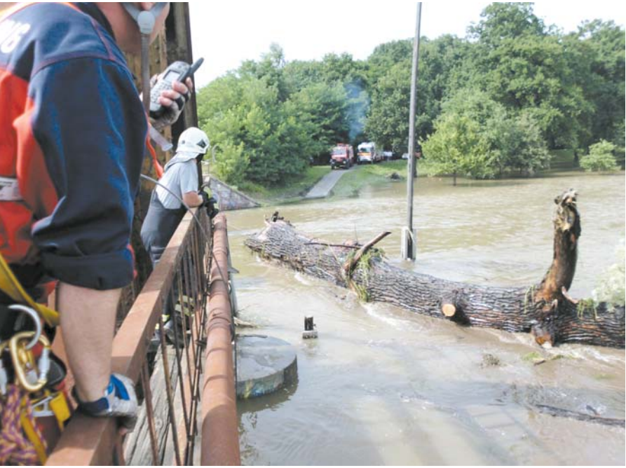
An diesem Eichen-Koloss biss sich sogar ein polnischer Panzer die „Zähne“ aus. Der 1,80 Meter dicke Stamm hatte sich unter der Gubener Eisenbahnbrücke (re.) verkeilt. Die Höhenretter von Vattenfall zersägten den Stamm, so dass er an Land gezogen werden konnte
