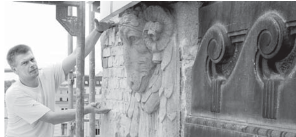
Maik Mückisch, Vorarbeiter der Schweizer GmbH, zeigt den Platz, wo ein irreparabler Widder seinen Platz hatte. In diesen Tagen wird der neue Kopf gegossen und angebracht
