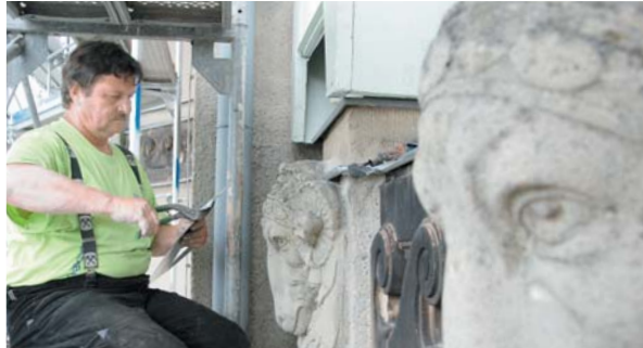
Für Klempnermeister Frank Kraftschenko, SK Dachbau GmbH Spremberg, ist die Theatersanierung keine Besonderheit, eher eine fummelige Arbeit wegen der vielen Figuren-Nischen
