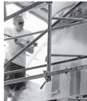
Stuckateur David Schwarz reinigt den alten Putz mit 250 Bar Wasserdruck. Das garantiert einen sauberen, festen Untergrund für den neuen Putz Fotos: Jens Haberland
