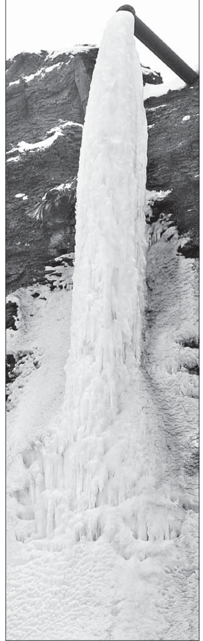
Dieses Rohr leitet Schmelz- und Regenwasser aus einem Auffangbecken zur Pumpstation eine „Etage“ tiefer. Der Frost hat sich hier ausgetobt und eine ca. zehn Meter hohe bizarre Säule entstehen lassen. Die Kumpel beobachten nun diese verstopfte Stelle und müssen bei Tauwetter notfalls per mobiler Pumpe das Wasser aus dem Oberbecken leiten
