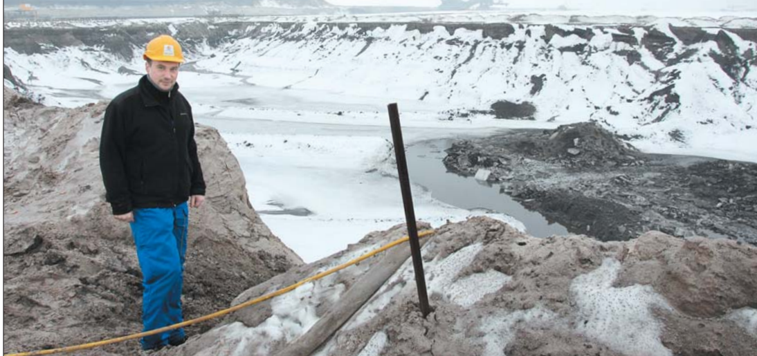
Steiger Michael Koppatz vor einem Aushubloch, das neu verfüllt wird, um der Förderbrücke ein sicheres Einschwenken in den nächsten Förderabschnitt zu sichern. Hier mussten diese Woche die Wasserpumpen rausgeholt werden, damit nichts einfriert. Bevor die Förderbrücke nächstes Jahr schwenken kann, muss das Wasser vorher aber weg sein - eine von vielen Aufgaben für die Entwässerungsprofis von Vattenfall in Welzow-Süd
