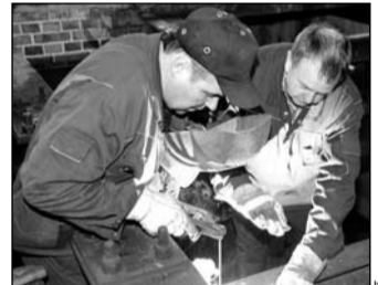
Betriebshandwerker bereiten die Kanalmodernisierung vor
