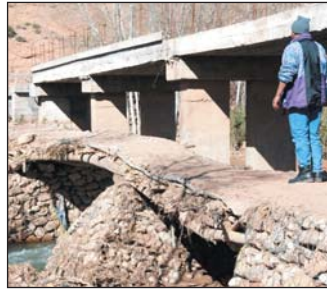
Auch im Wege- und Brückenbau ist Materialwechsel
